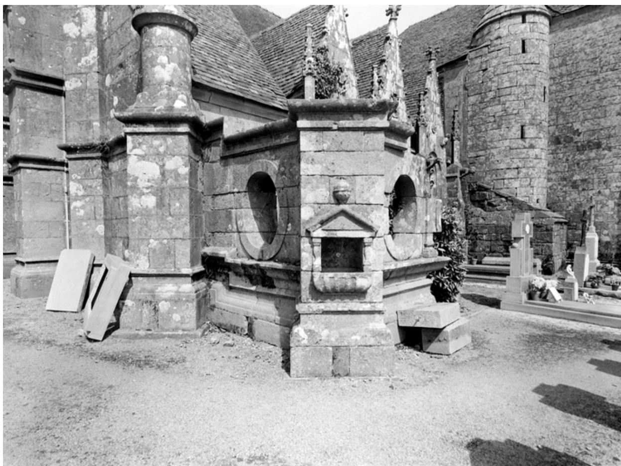
Ossuaire : vue de l'angle sud-ouest
