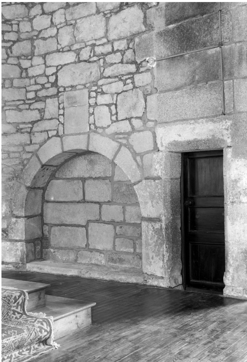
Mur nord du choeur : porte et enfeu
