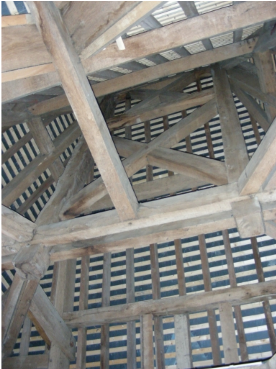
Vue de la charpente, partie sud
