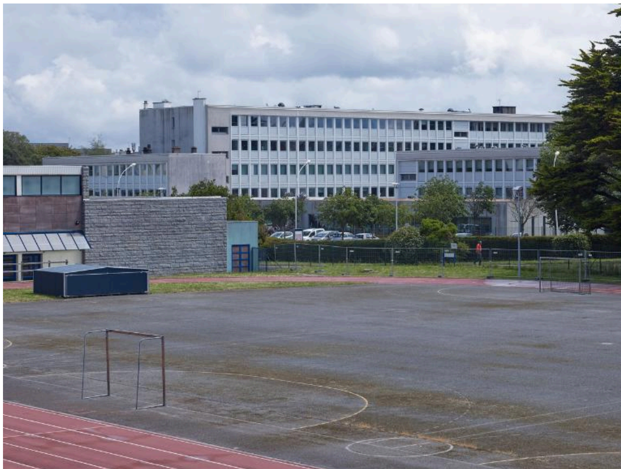
Vue d'ensemble du lycée et de son entrée, prise depuis le lycée Colbert.
