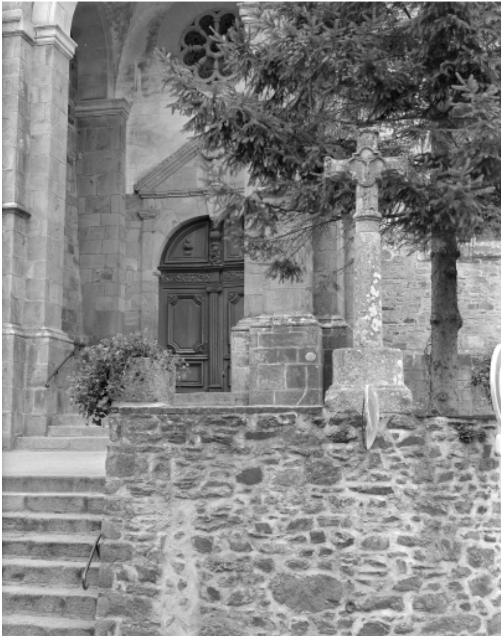
Elévation ouest, porte d'entrée : vue générale
