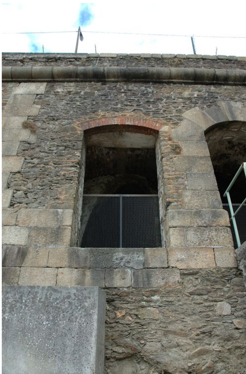
Vue des latrines collectives (contre-plongée) : porte gauche aménagée ultérieurement et détail de la maçonnerie en pierre de taille de granite
