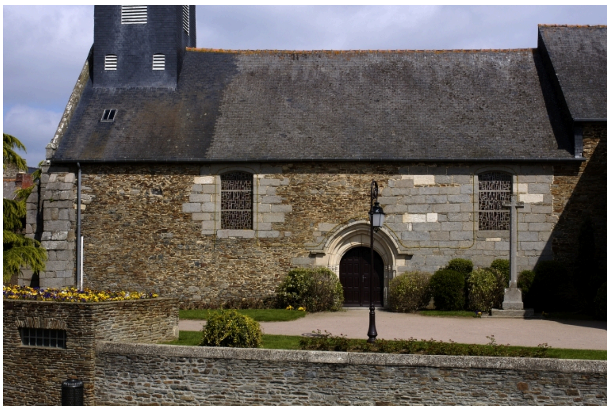
Vue partielle sud
