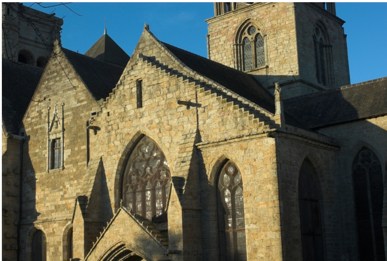
Vue générale du bras sud
