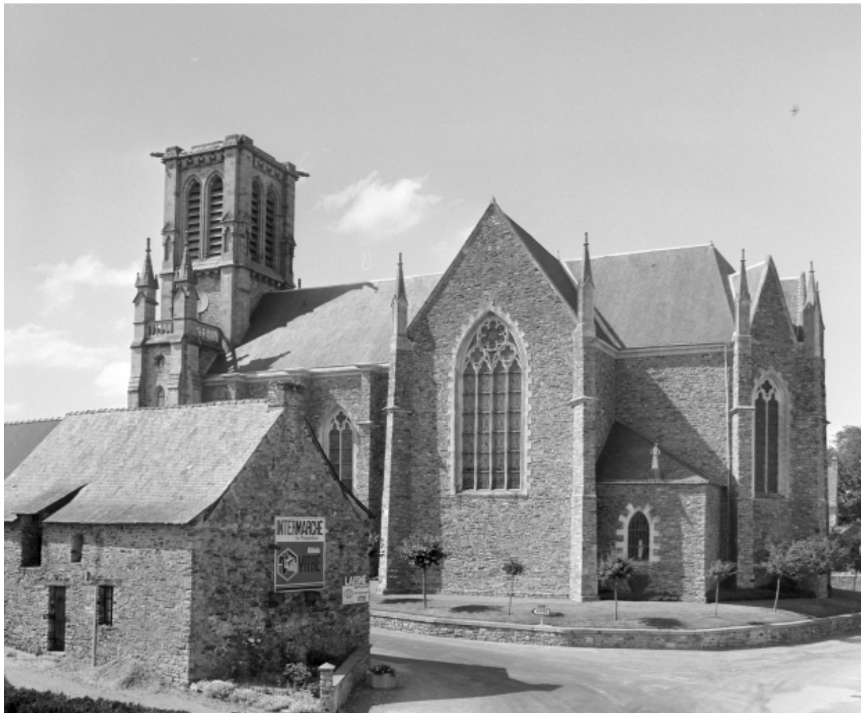
Elévation sud, vue générale prise de l'est.
