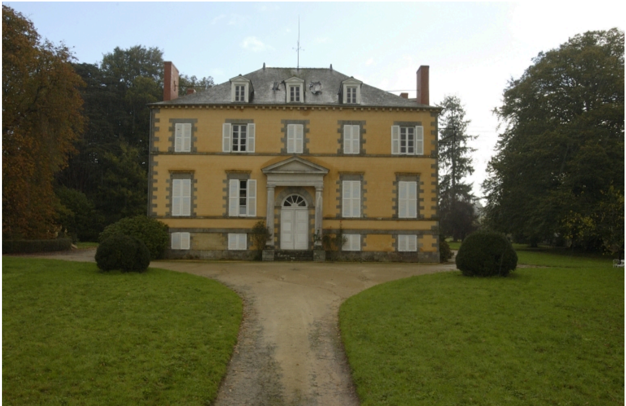
Élévation ouest : vue générale
