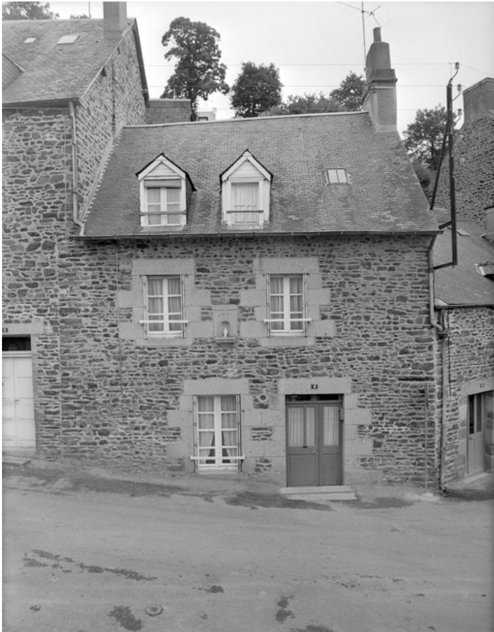
Elévation antérieure, vue générale.
