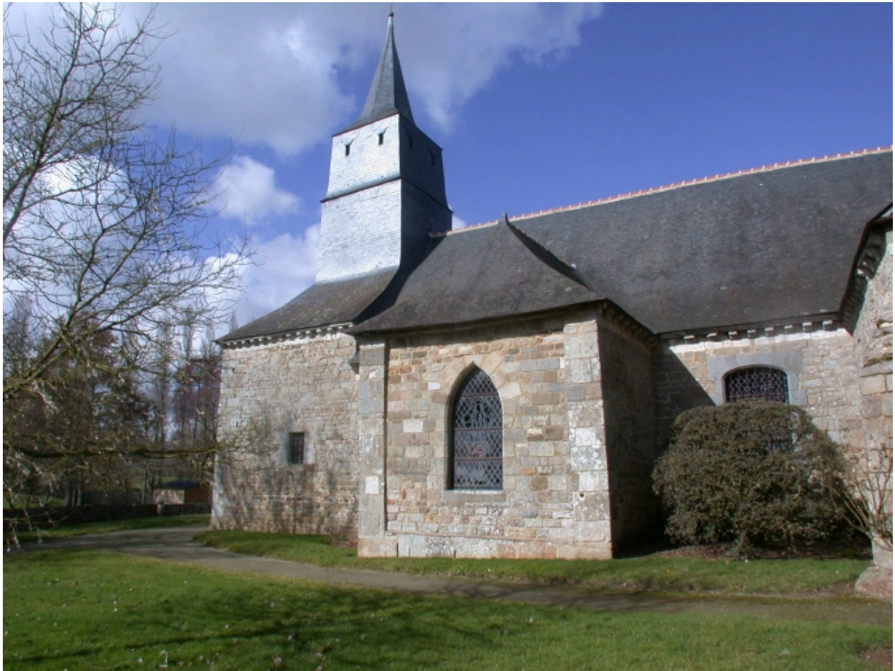
Façade Sud, ossuaire
