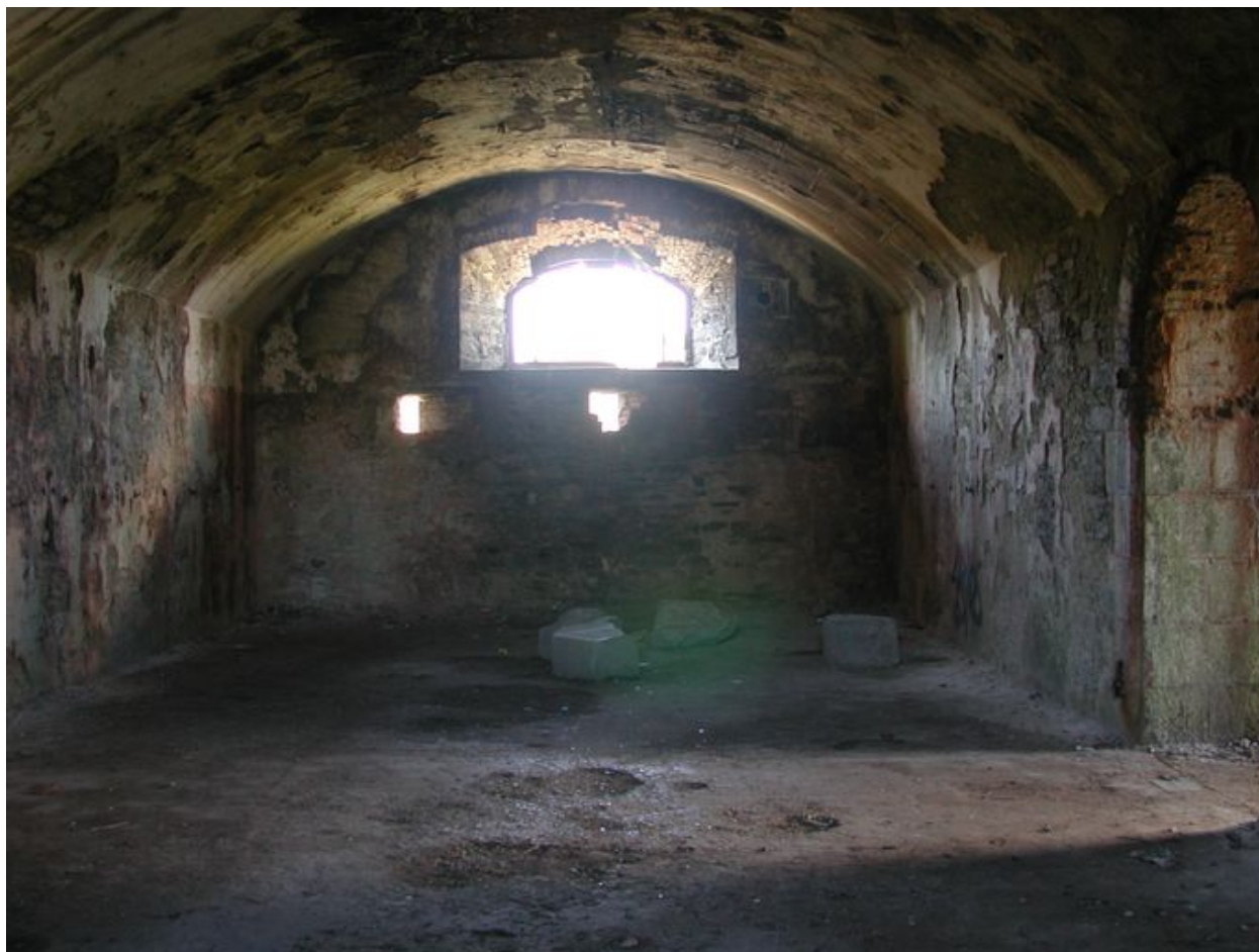
Vue du réduit de batterie de côte de l'île de l'Aber : salle voûtée
