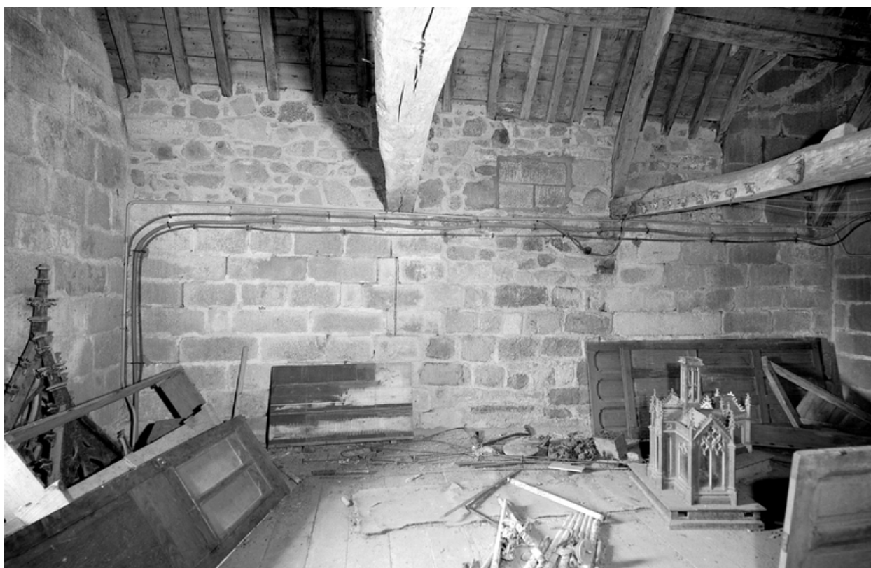
Sacristie : 2ème étage : mur ouest
