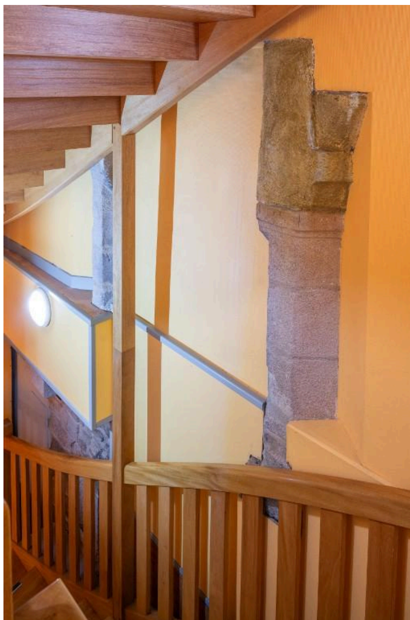
Vestiges de cheminée dans le pignon ouest.
