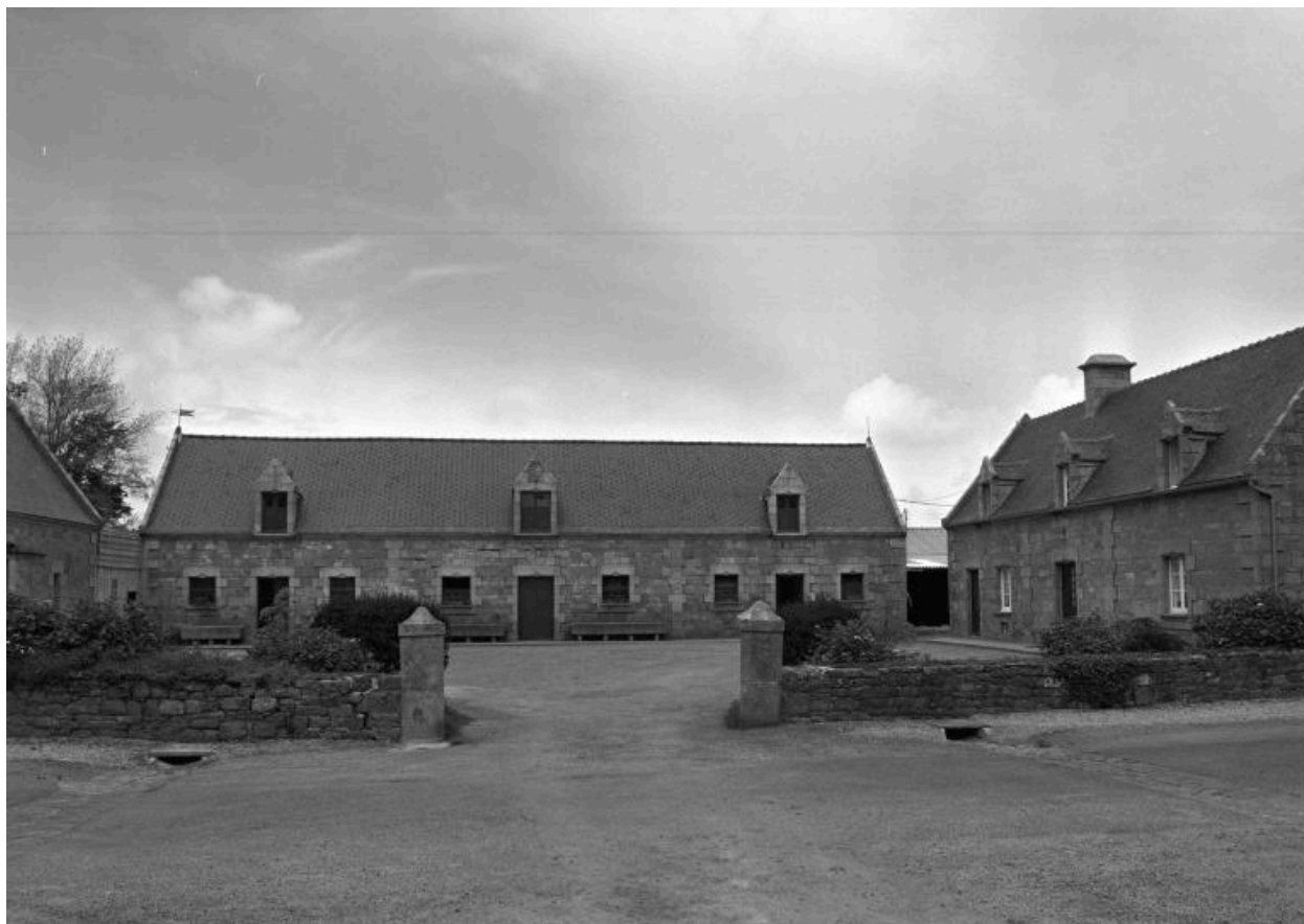
Ferme en face de l'entrée, vue générale sud
