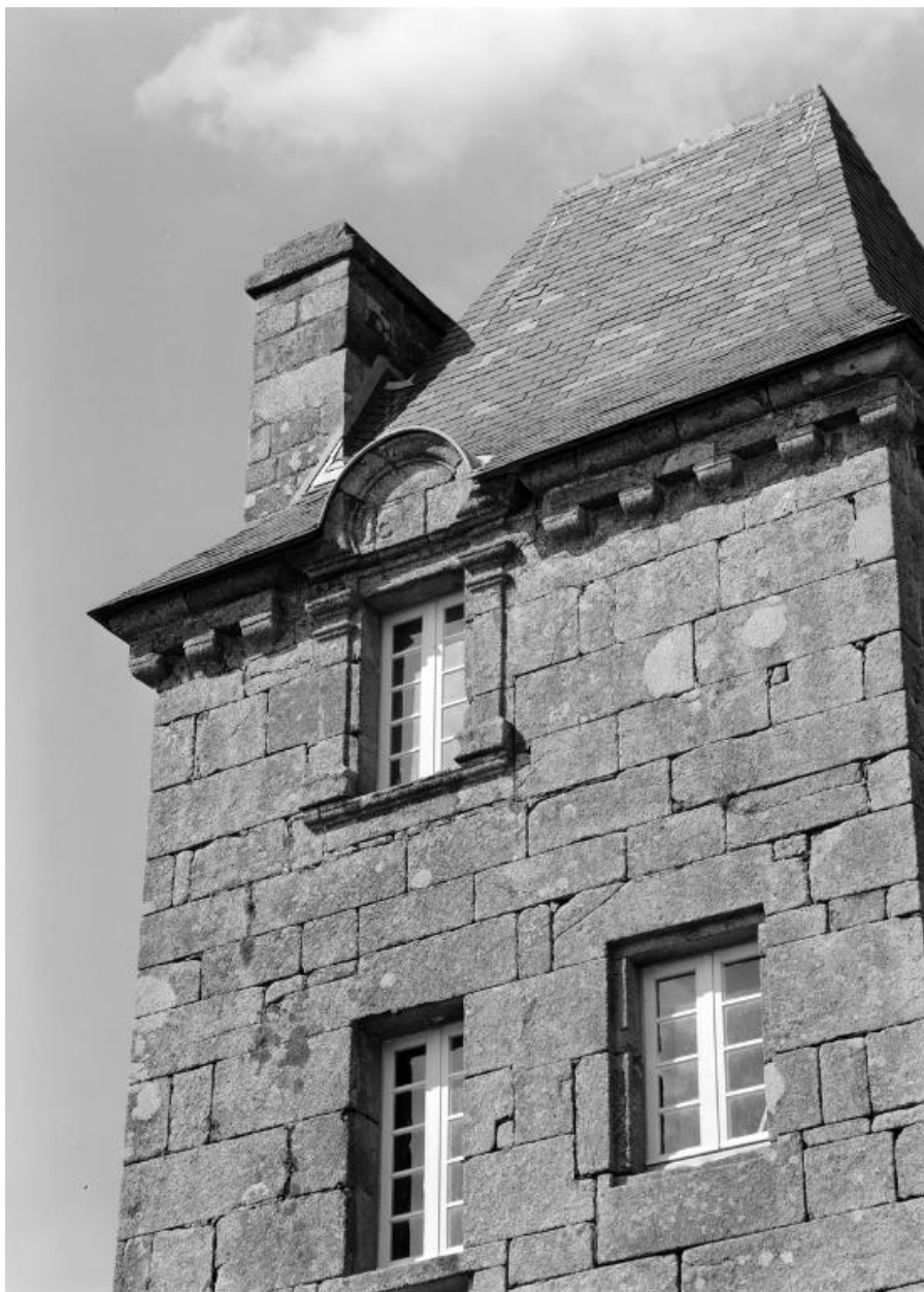
Détail ouvertures aux 3e et 4e niveaux, sur la face de la tour au sud-ouest
