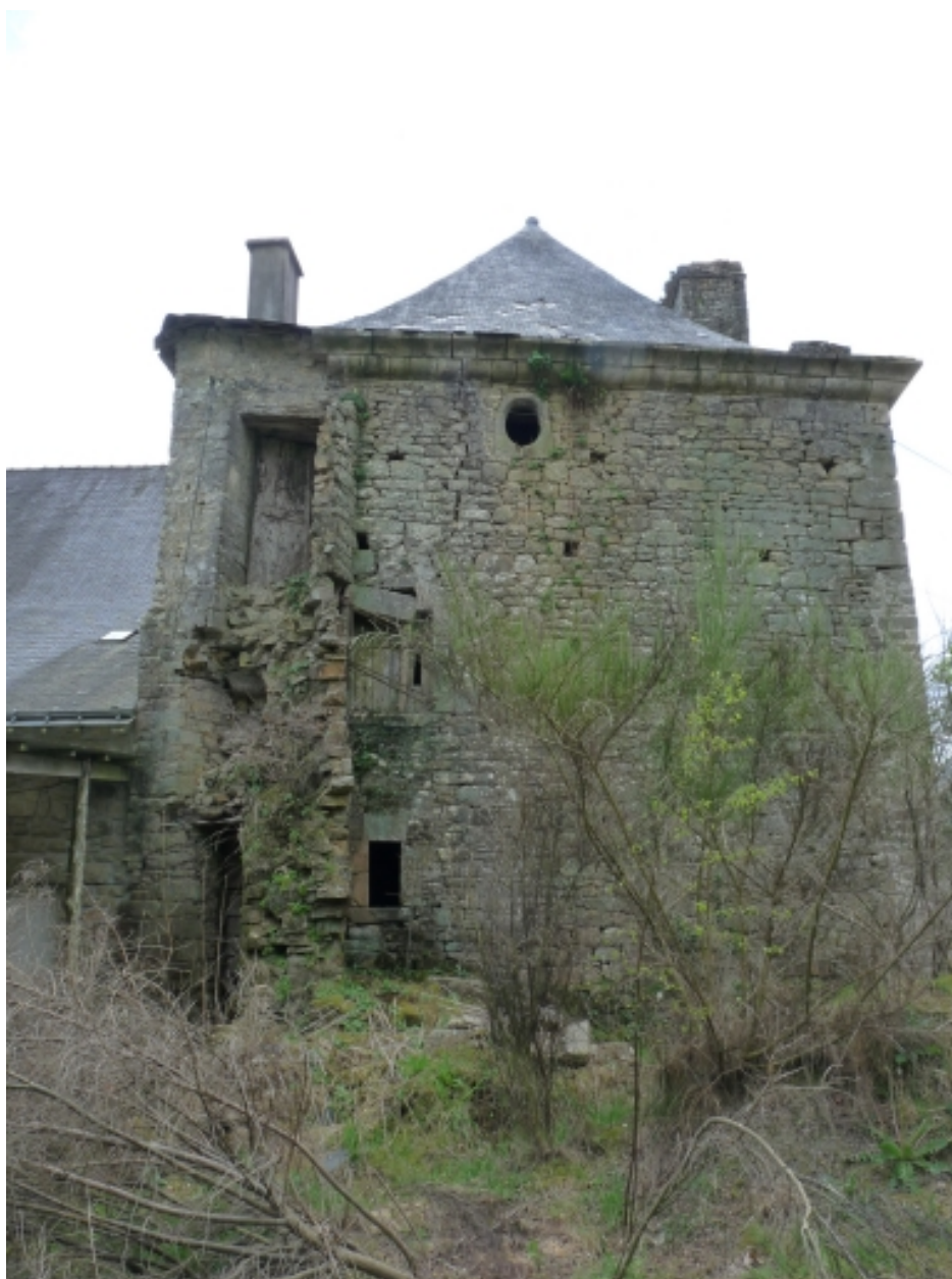
Elévation nord, vestige de l'escalier et trace de reprise dans la chaîne d'angle
