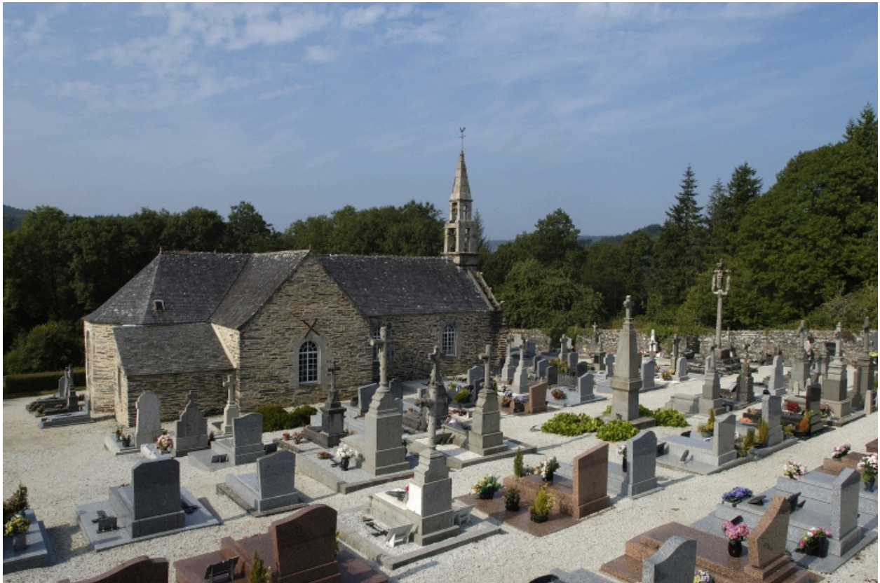
Saint-Rivoal, église paroissiale Saint-Rivoal : vue générale nord-est
