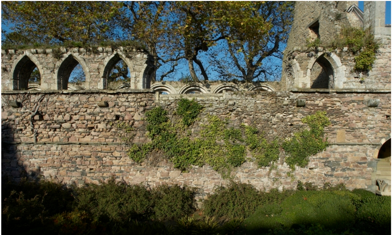
Mur sud du réfectoire
