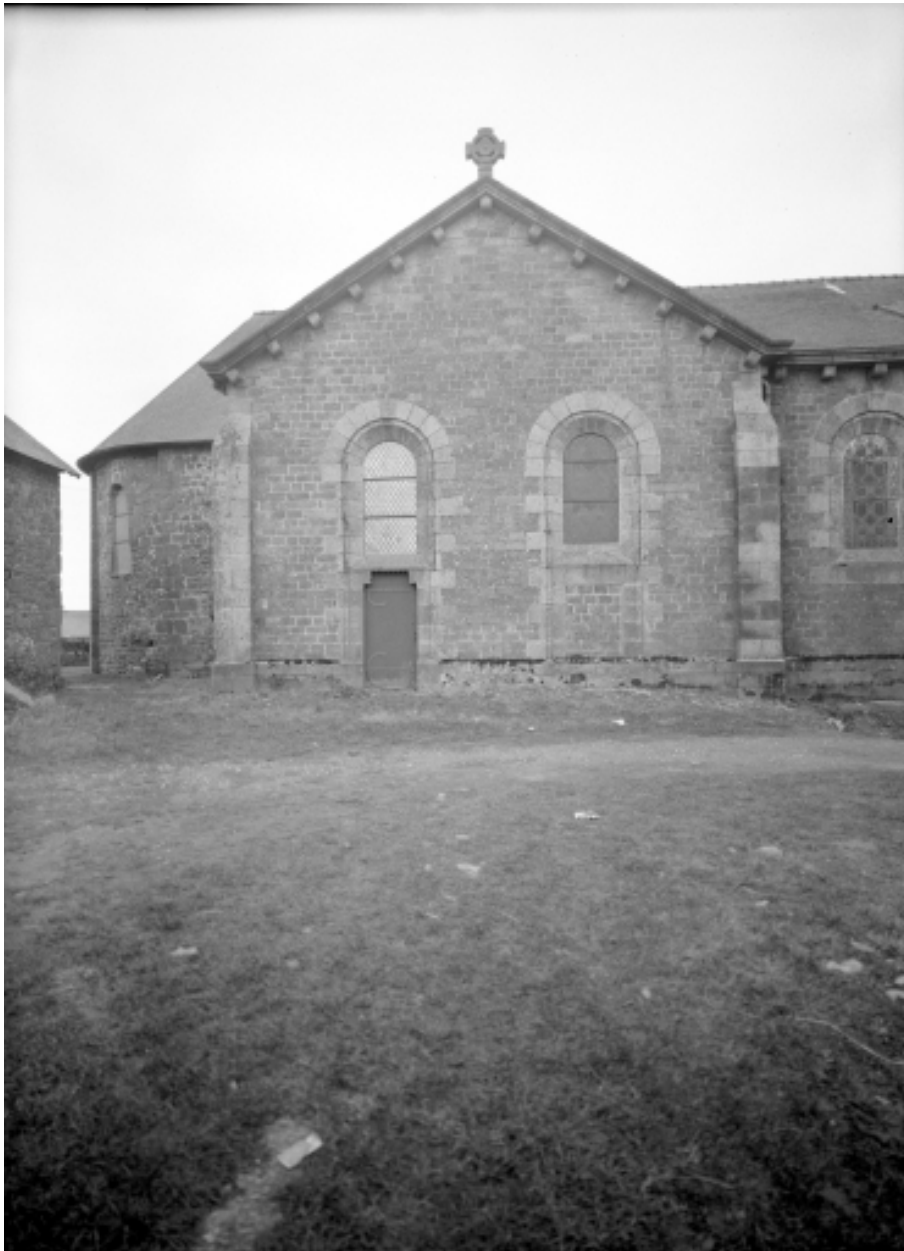
Elévation Nord, bras du transept : vue générale
