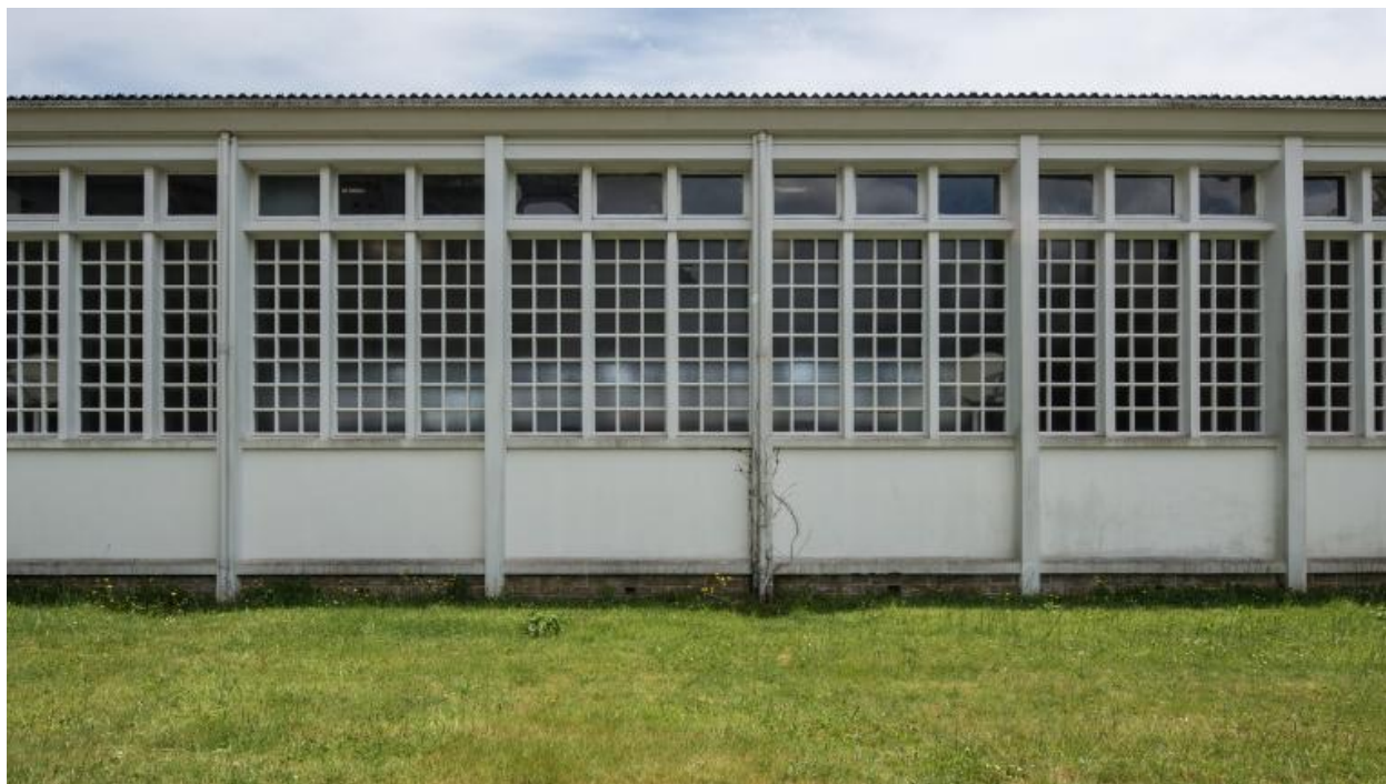
Partie centrale de la façade nord-ouest
