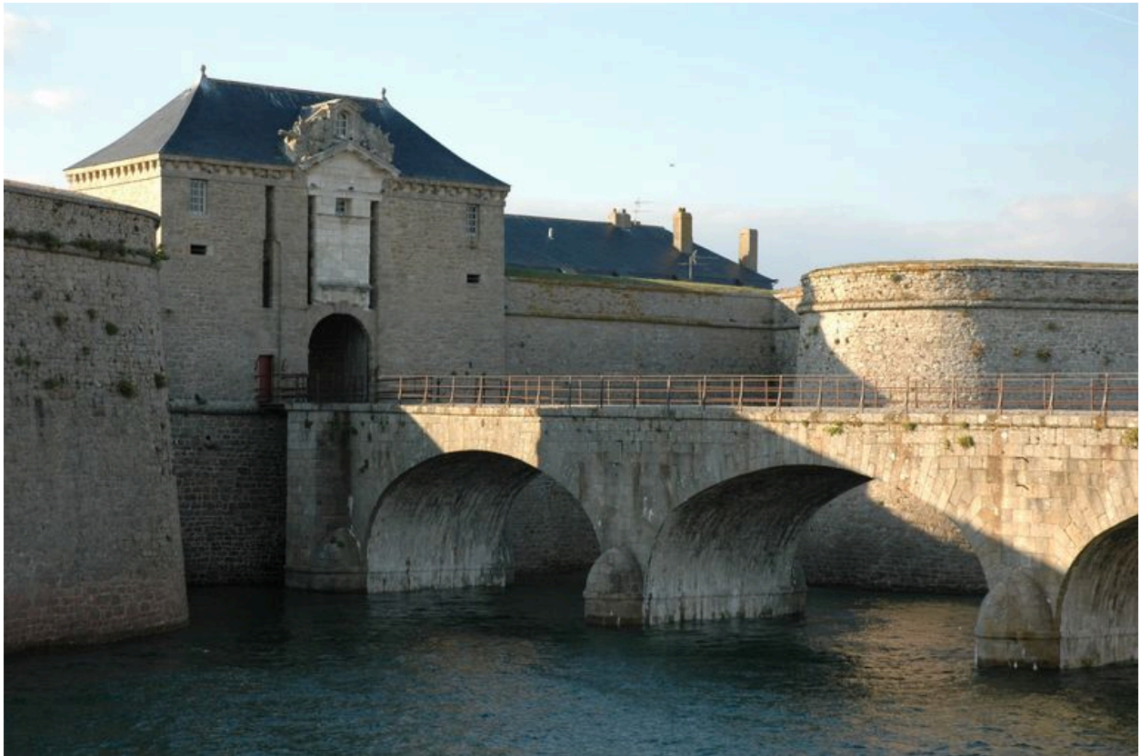
Vue de la citadelle de Port-Louis : porte monumentale du corps de place
