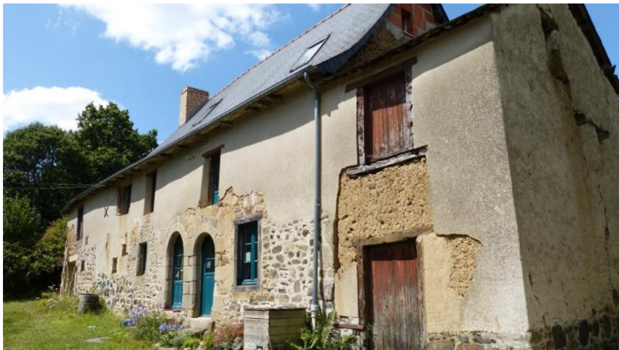
Vue générale sud est, Montdidier (Hédé-Bazouges)
