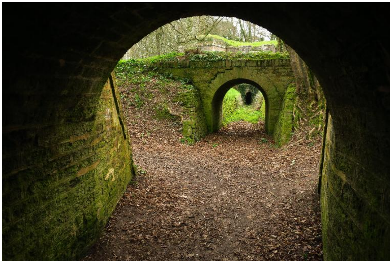
Le Palais, enceinte urbaine, courtine 19-20, place d'armes.
