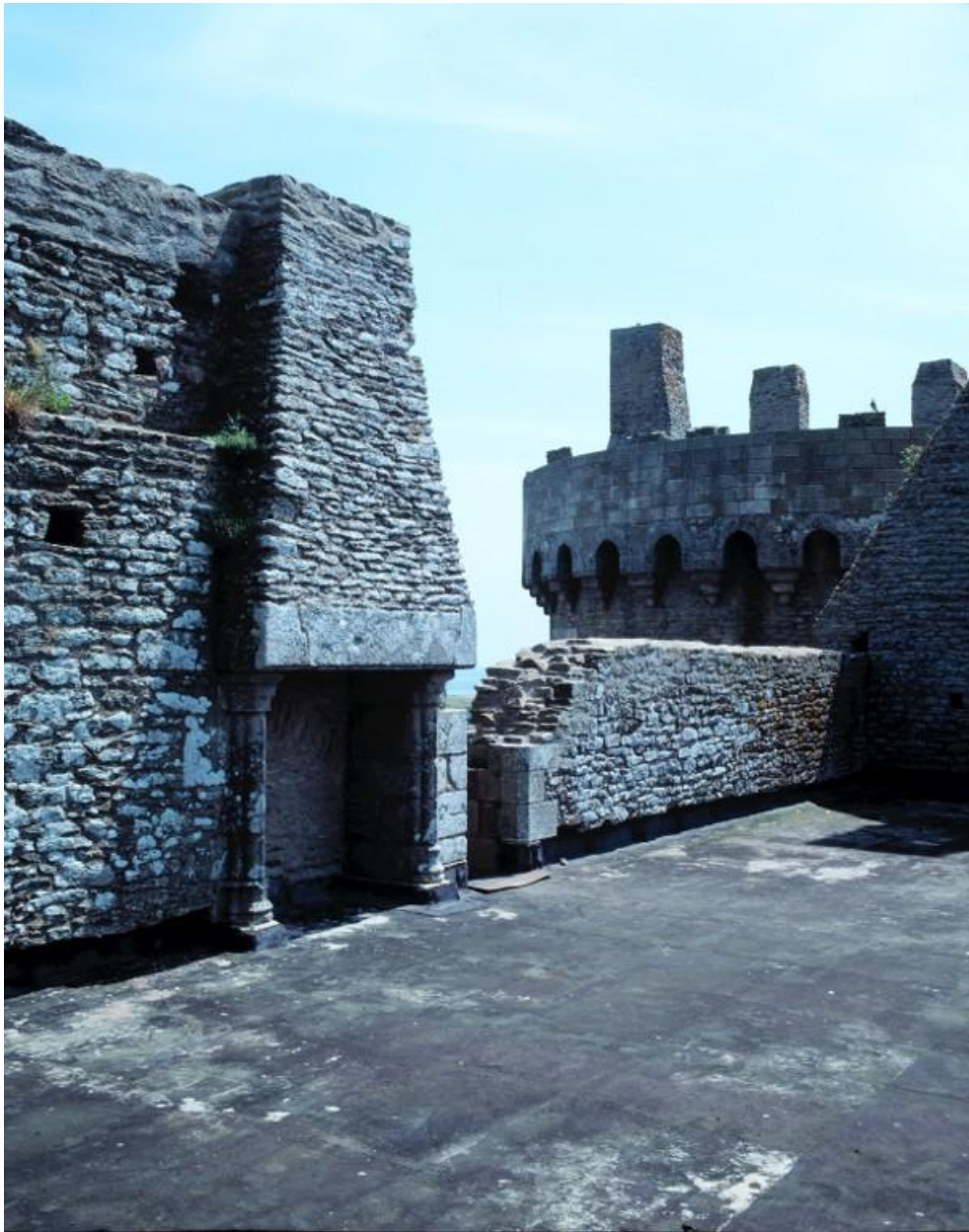
Château fort, logis est, étage de comble, salle : mur est, cheminée.
