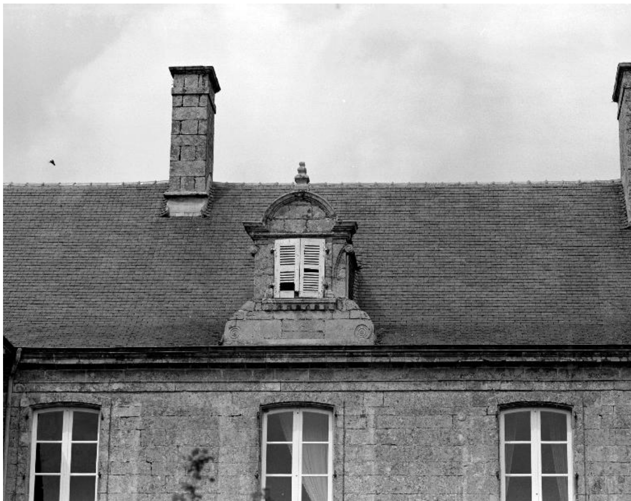
Elévation sud, corps central, lucarne.
