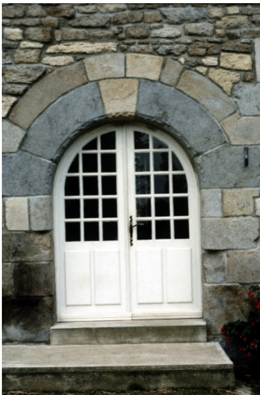
La Basse Biliais : porte élévation sud
