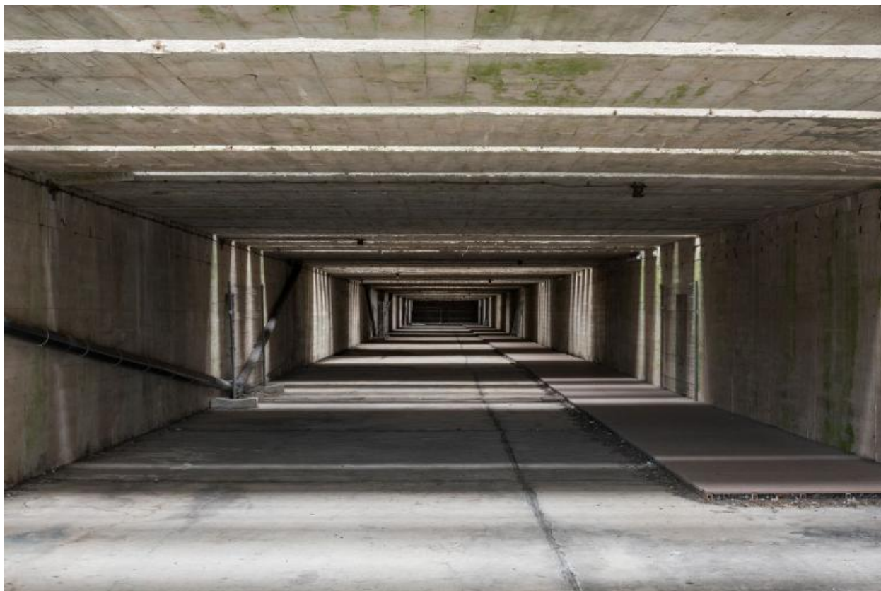
Vue générale de l'une des chambres d'explosion
