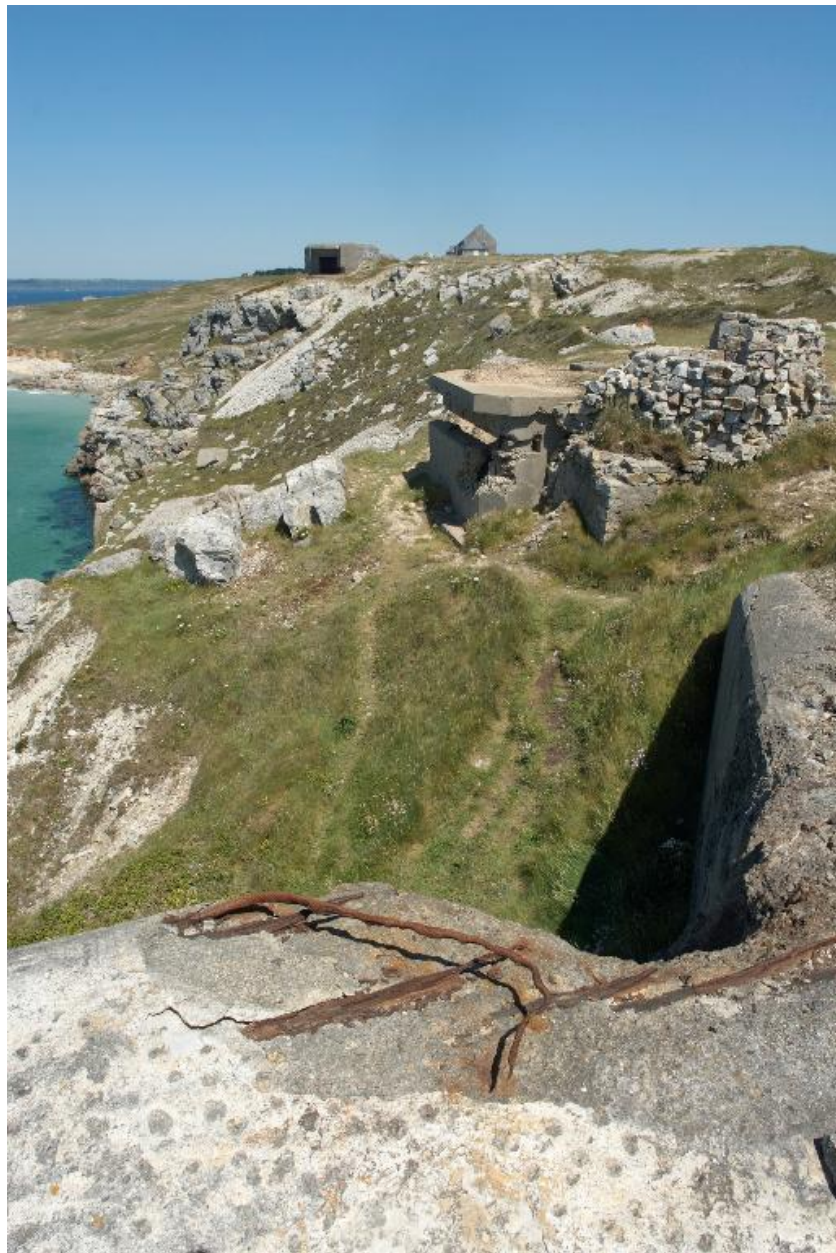
Vue de l'observatoire en béton armé de la batterie française de Kerbonn (4 canons de 164,7 mm)
