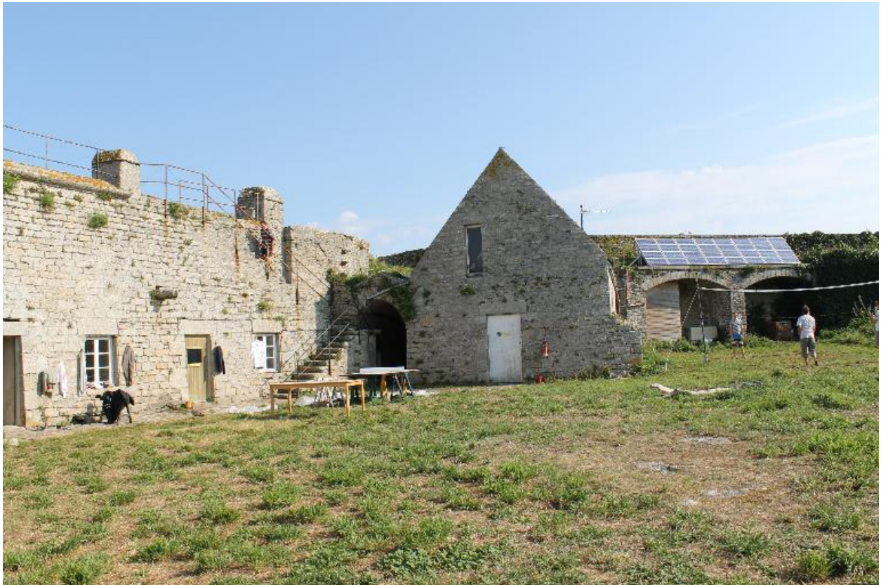
Intérieur du fort avec la maison des officiers
