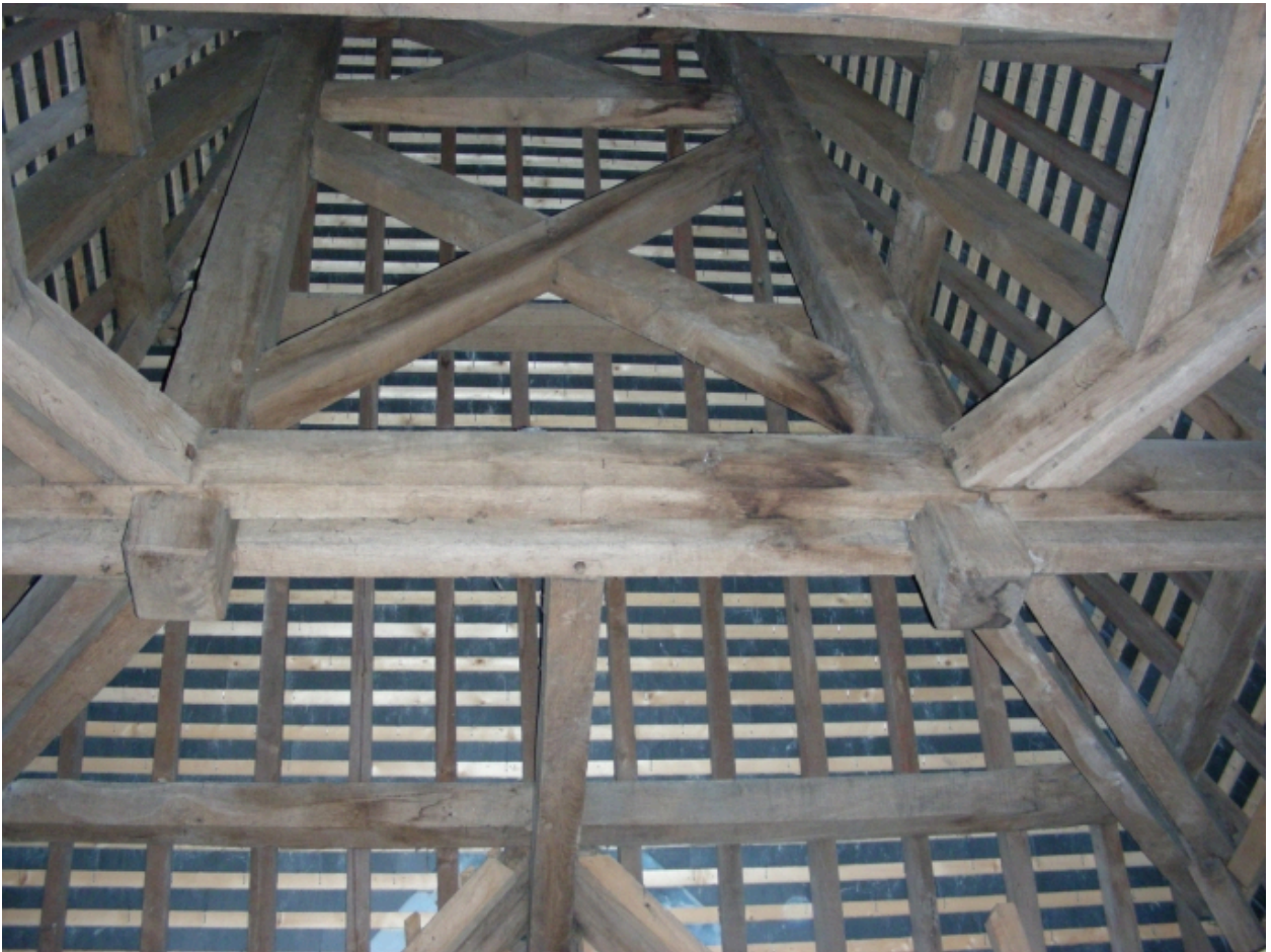
Vue de la charpente, partie sud
