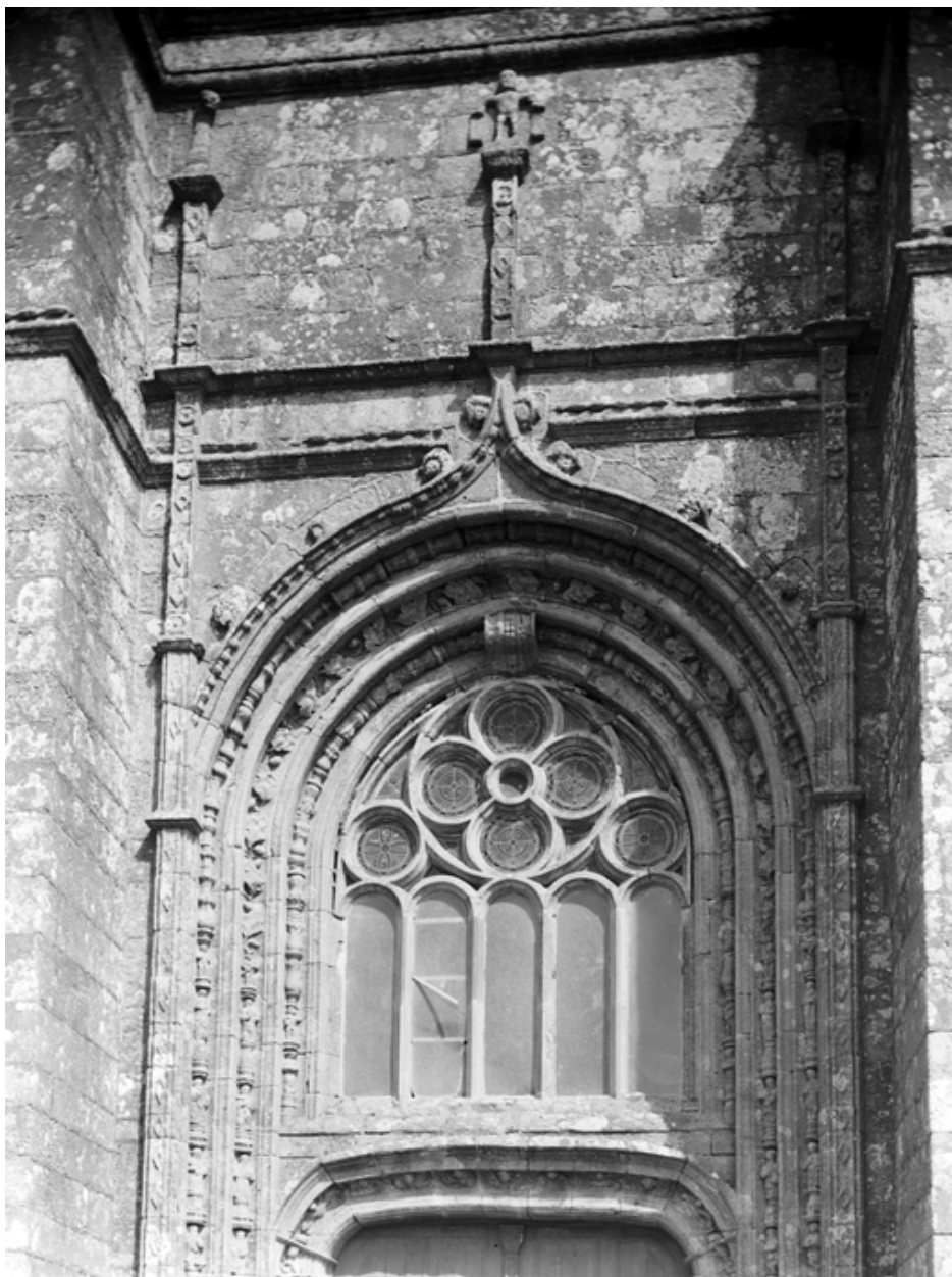
Ressaut de la baie ouest
