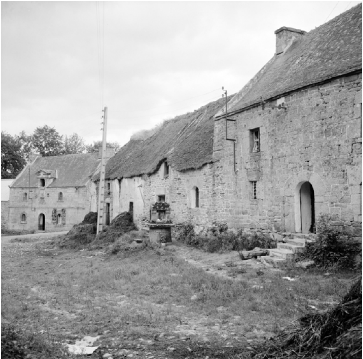
Kerdanet, alignement de maisons : vue de situation prise du nord-est
