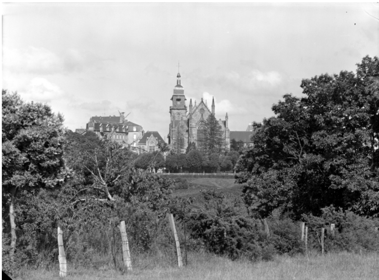
Vue de situation ouest.
