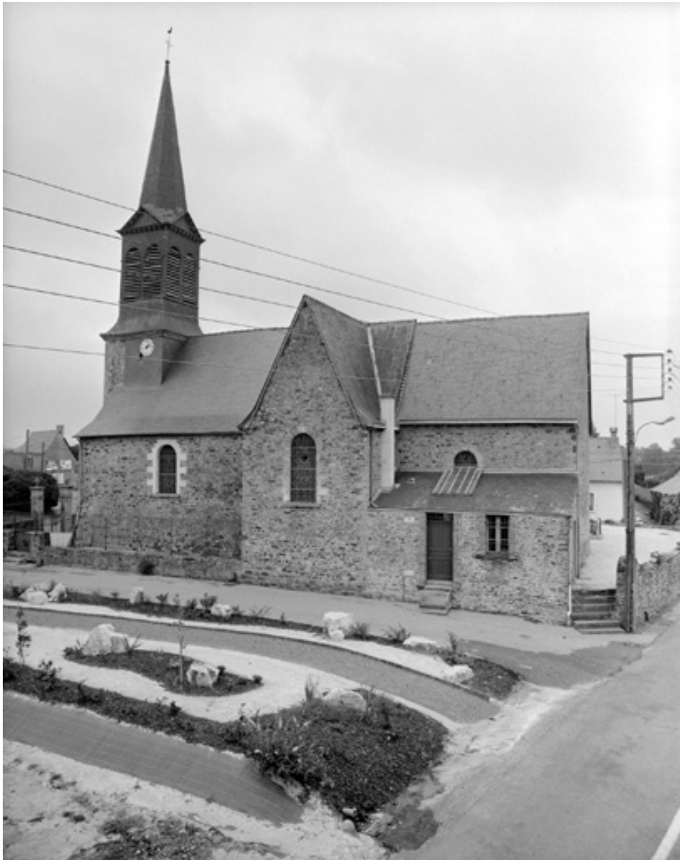
Élévation sud : vue générale
