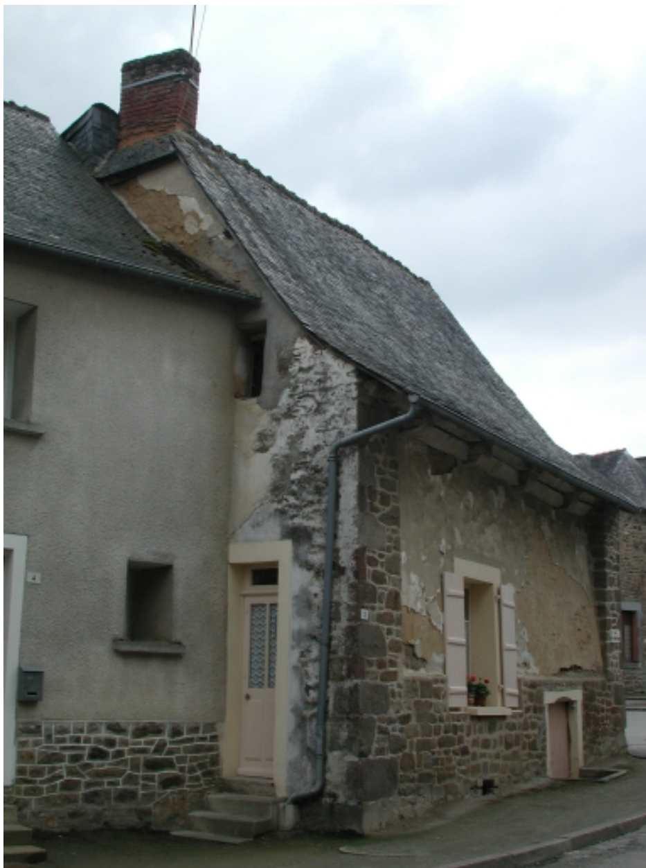
Vu générale nord-est
