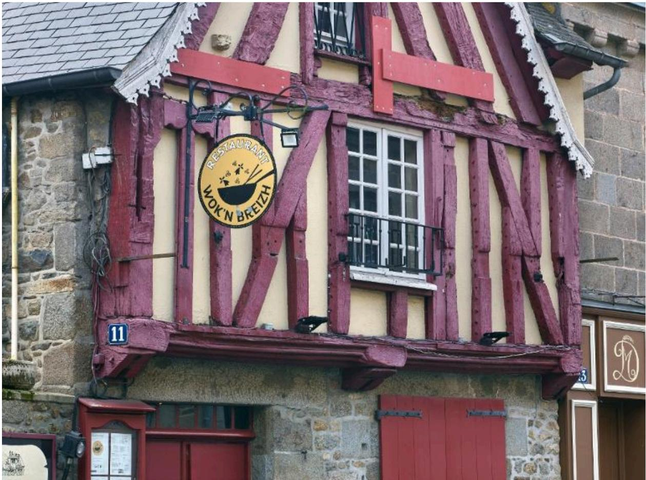
Ce pignon en pan de bois a subi de nombreuses modifications : reprise du rez-de-chaussée en maçonnerie avec suppression des poteaux, modification des baies et disparition de l'appui filant, remplacement du hourdis, recul de la toiture...
