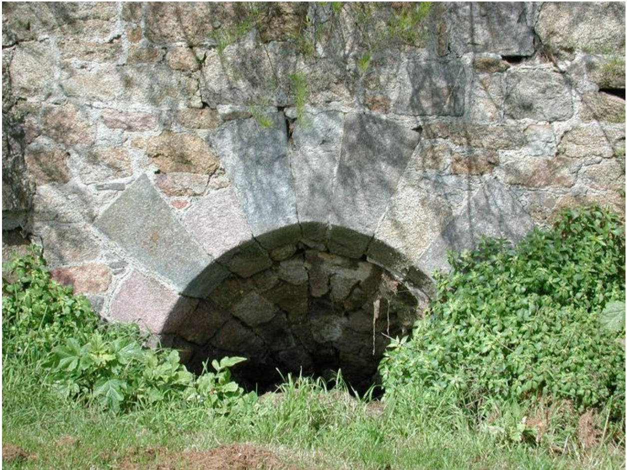
Vue de l'élévation Est : accès en arc plein cintre au foyer (état en 2002)
