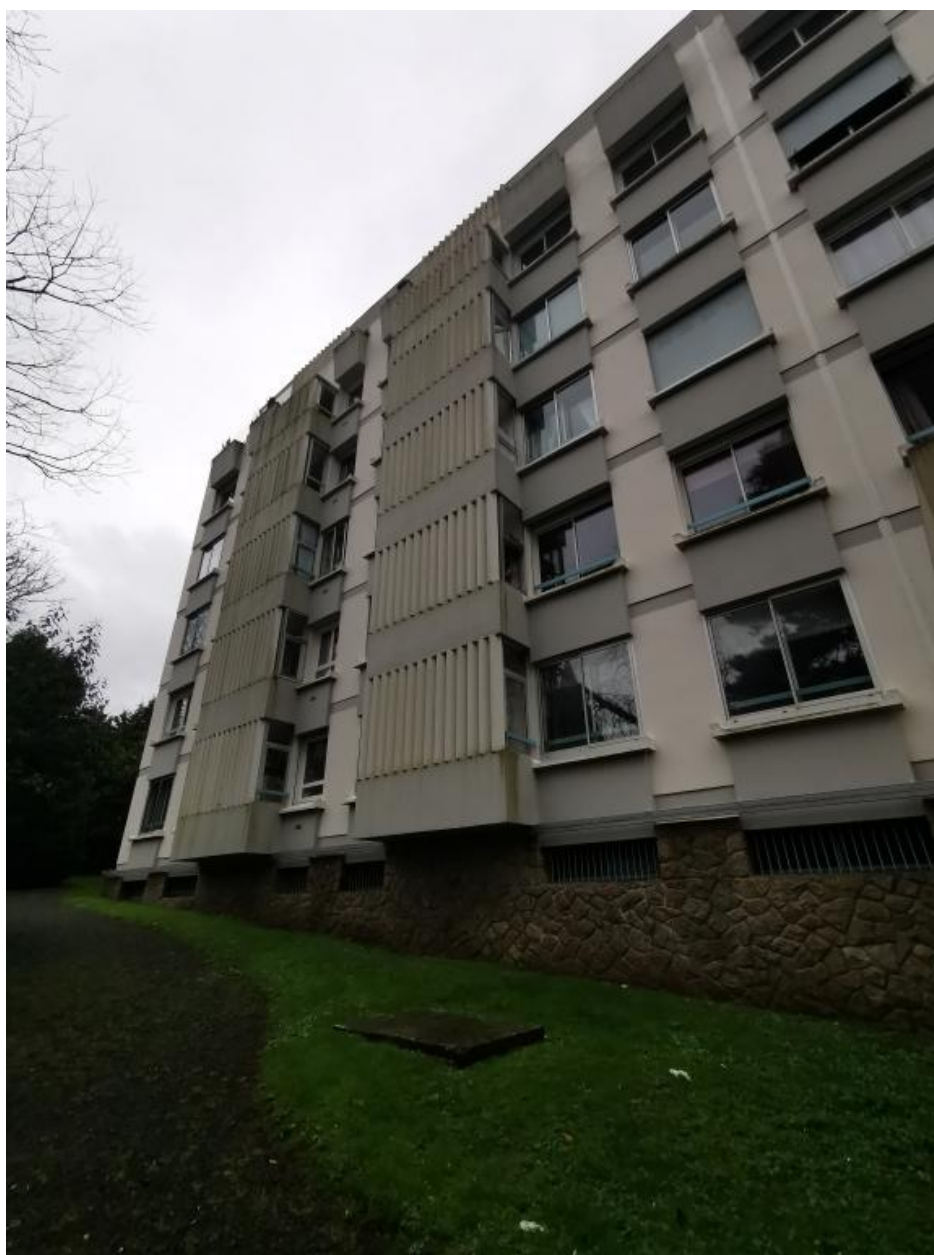
Vue de la façade côte nord
