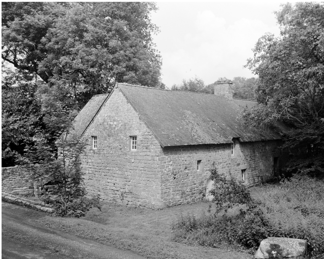
Moulin, vue générale sud-ouest.
