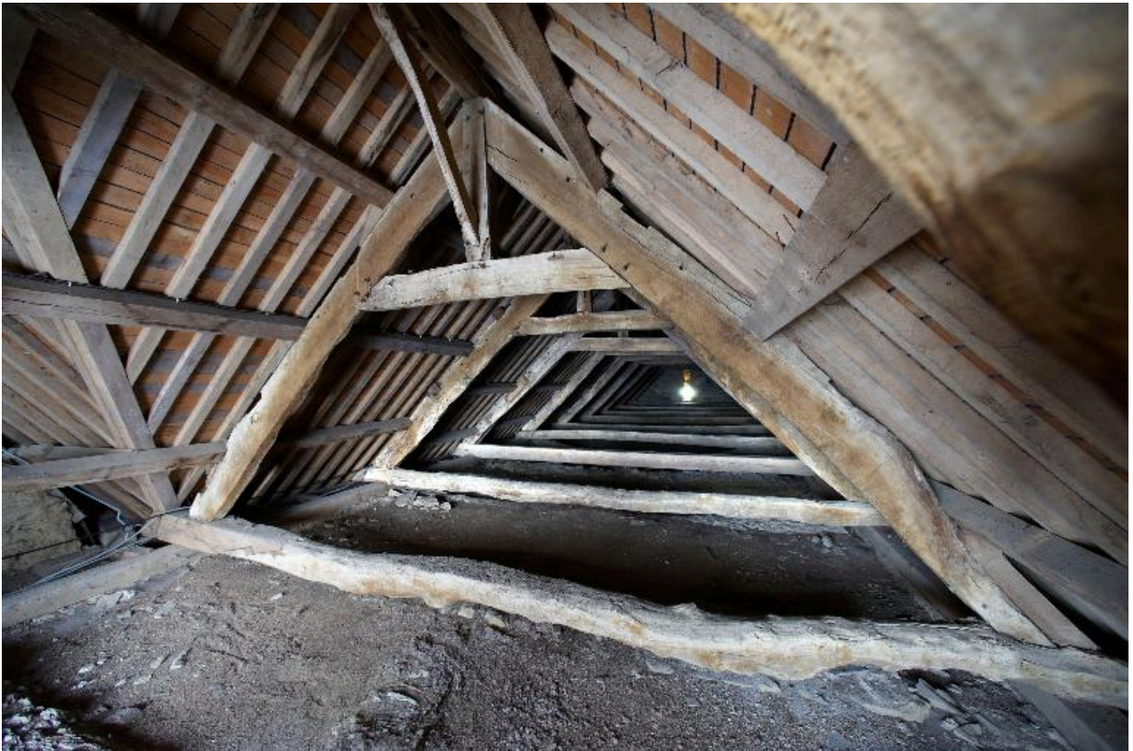
Charpente du vaisseau central, vue générale vers l'ouest.
