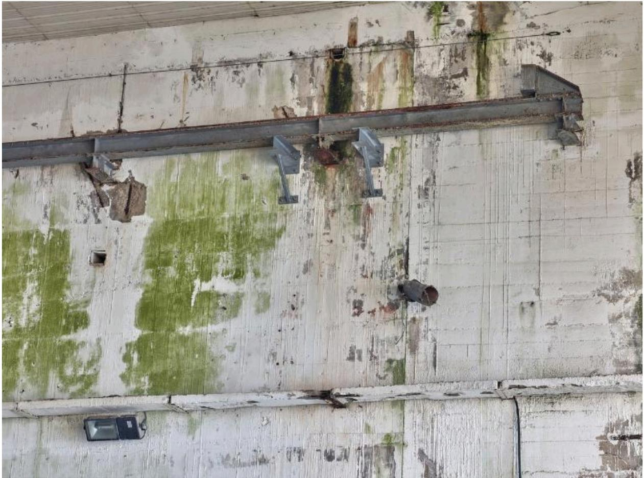
Vue de l'alvéole E (n° 17 et 18) : côté quai est n° 17, chemin de roulement du pont-roulant et projecteur dirigé vers les portes d'écluse
