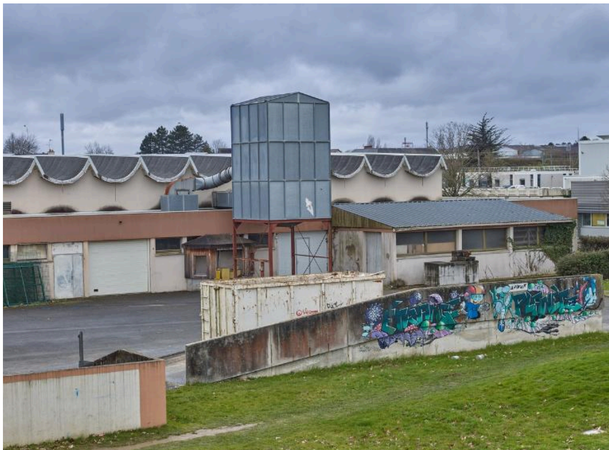
Ateliers : détail sur la façade est et le silo.
