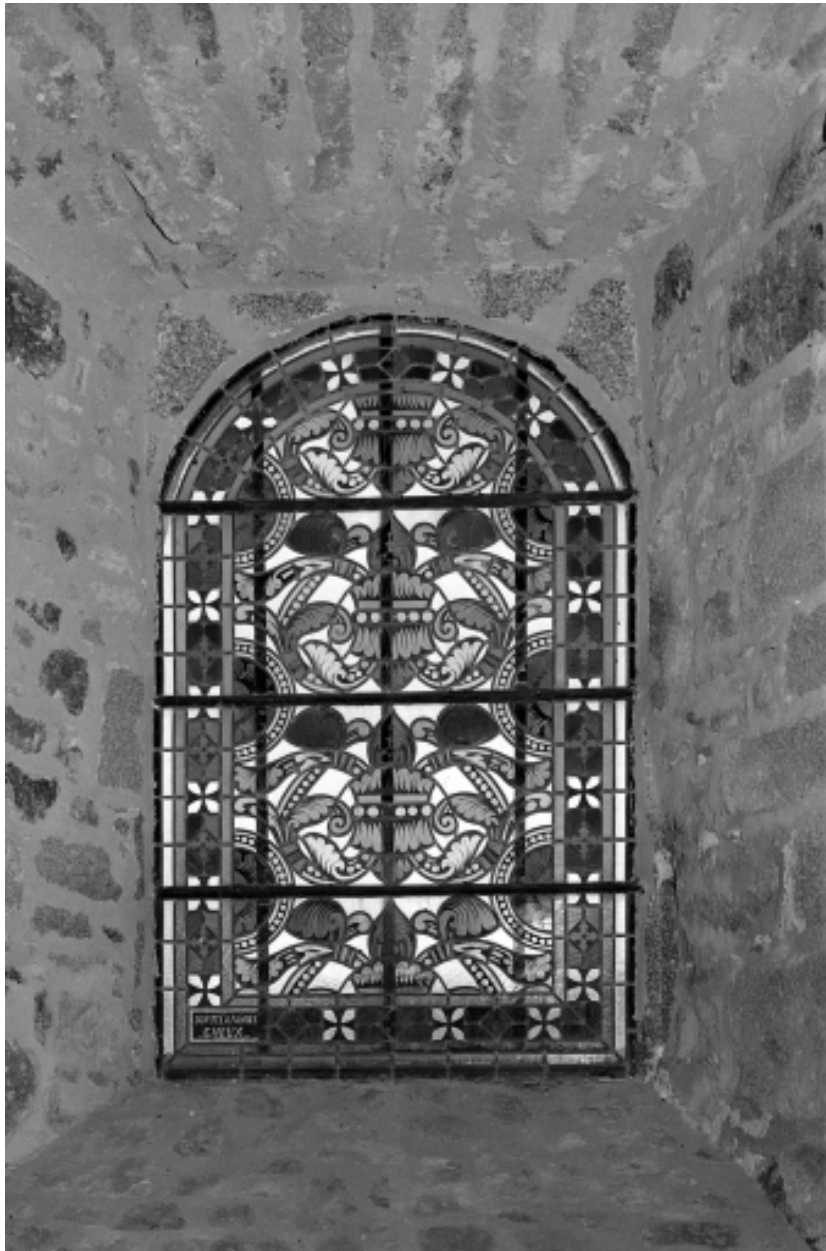
Mur sud, fenêtre 1, vue générale.
