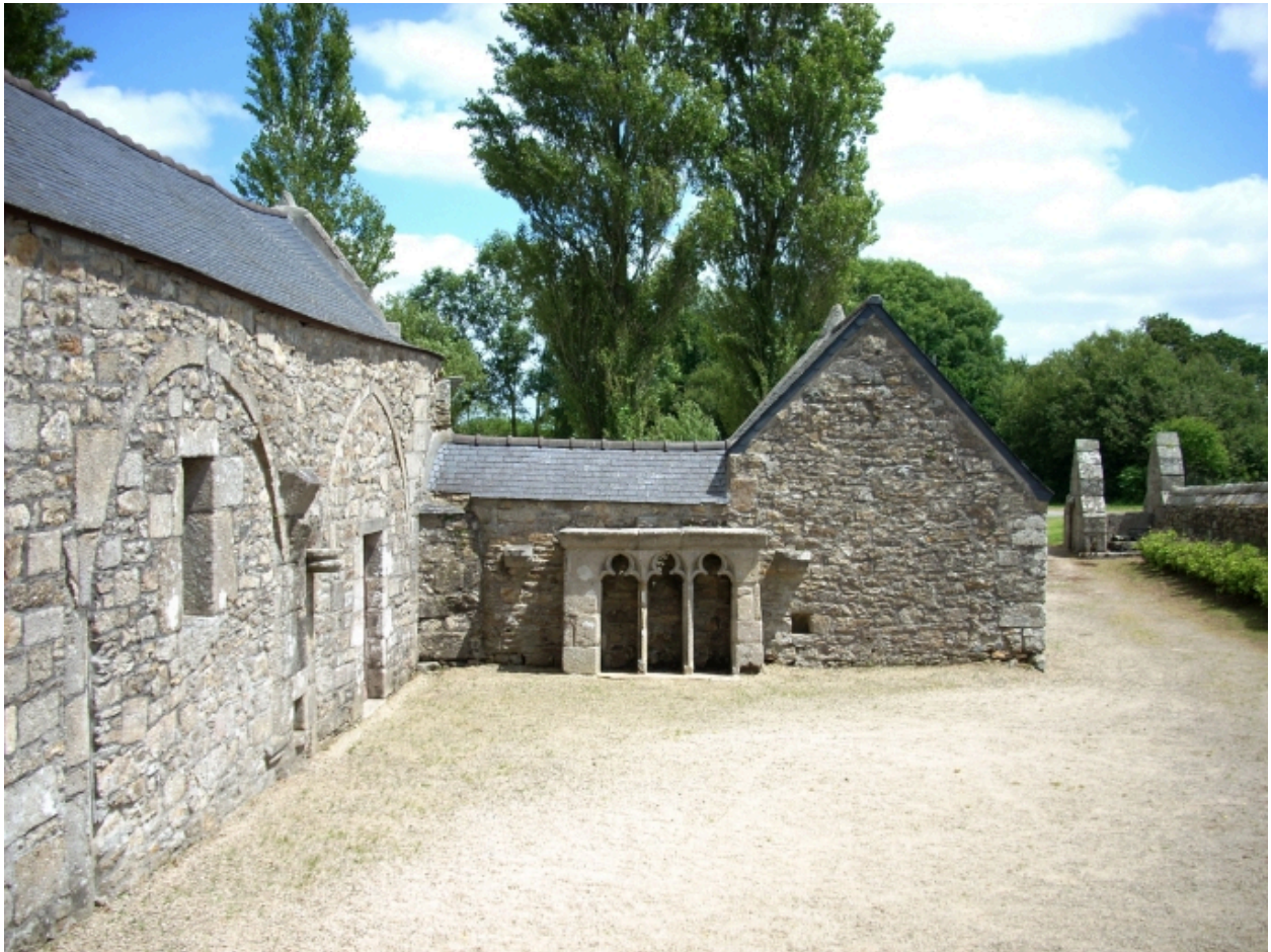
Saint-Vougay, chapelle Saint-Jean-Baptiste : vue générale ouest de l'ossuaire, détail
