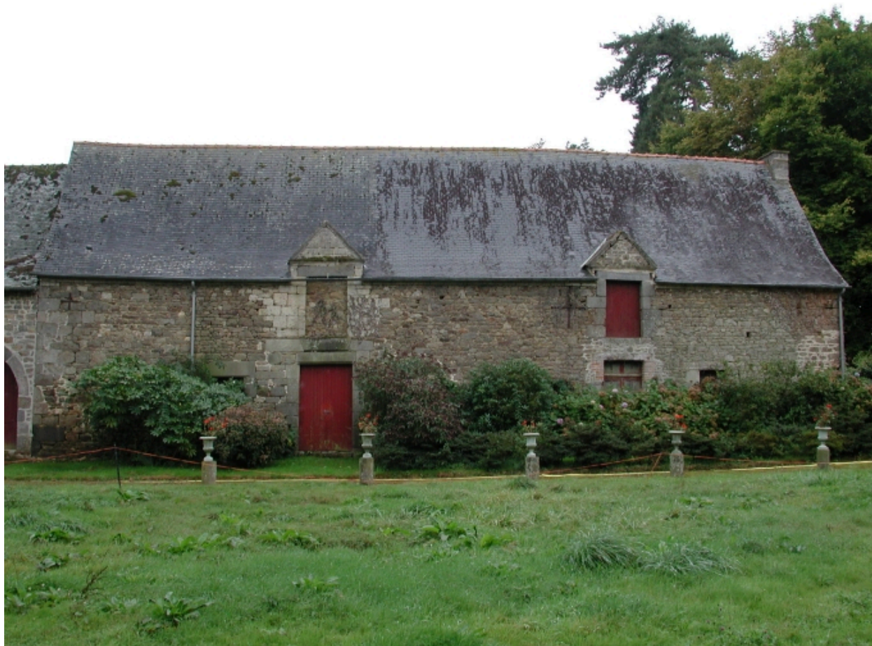
Aile sud des communs : vue générale
