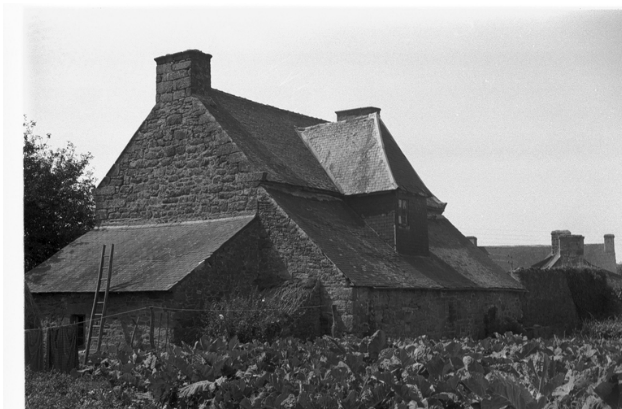
Vue de situation prise du nord est
