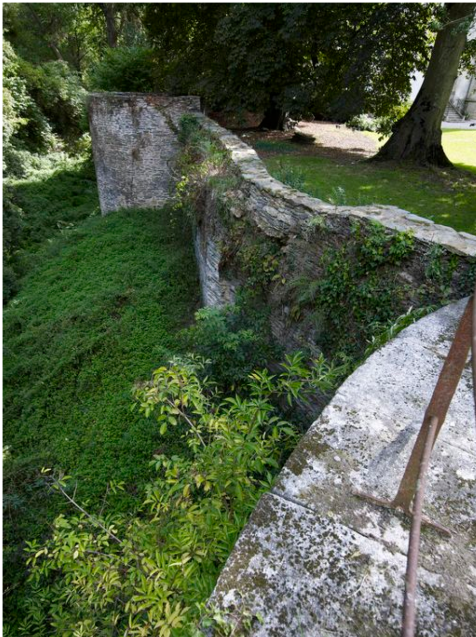
Château, ancienne enceinte au nord : vue générale vers l'est (état en 2010)
