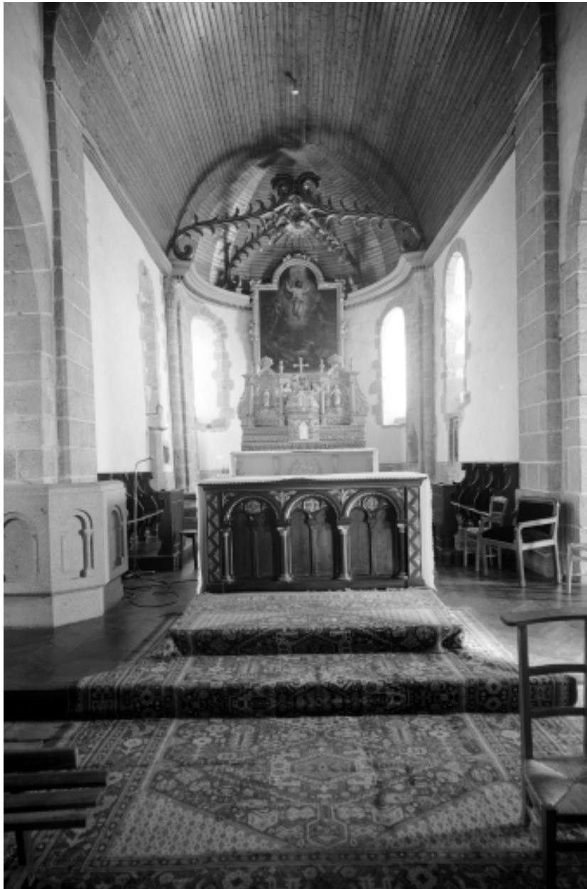
Intérieur, chœur : vue générale.
